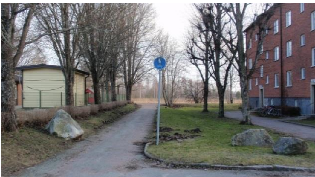
Gång- och cykelvägen mellan Orgeltramparen 12 och Kyrkvaktaren 1
