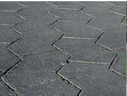
SF-sten markerar angörings- och uppställningsyta.
