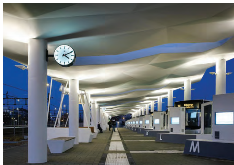
Intressant belysning på taket av perrongtaket.
