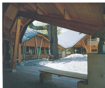
Exempel på tak och fasad i trä.
