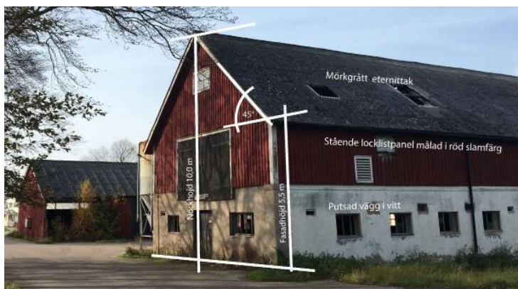
Stallbyggnaden dominerar områdets karaktär och har koppling till platsens historia.
