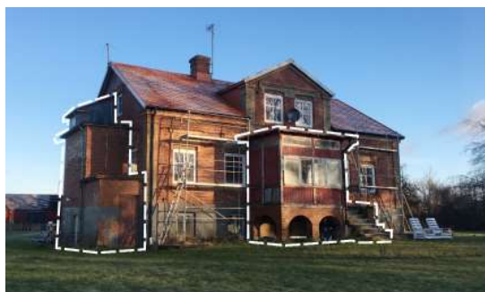
Fasader mot söder och väster har byggts till med funkisstil (markerade i vitt).
