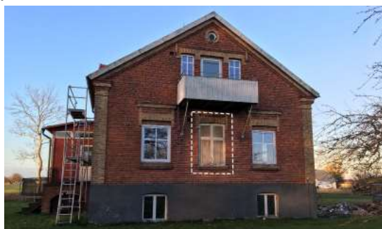
Fasad mot öster är välbevarat. Blindfönster (markerad i vitt) som visar hur tidigare fönster i slutet av 1800-talet såg ut.
