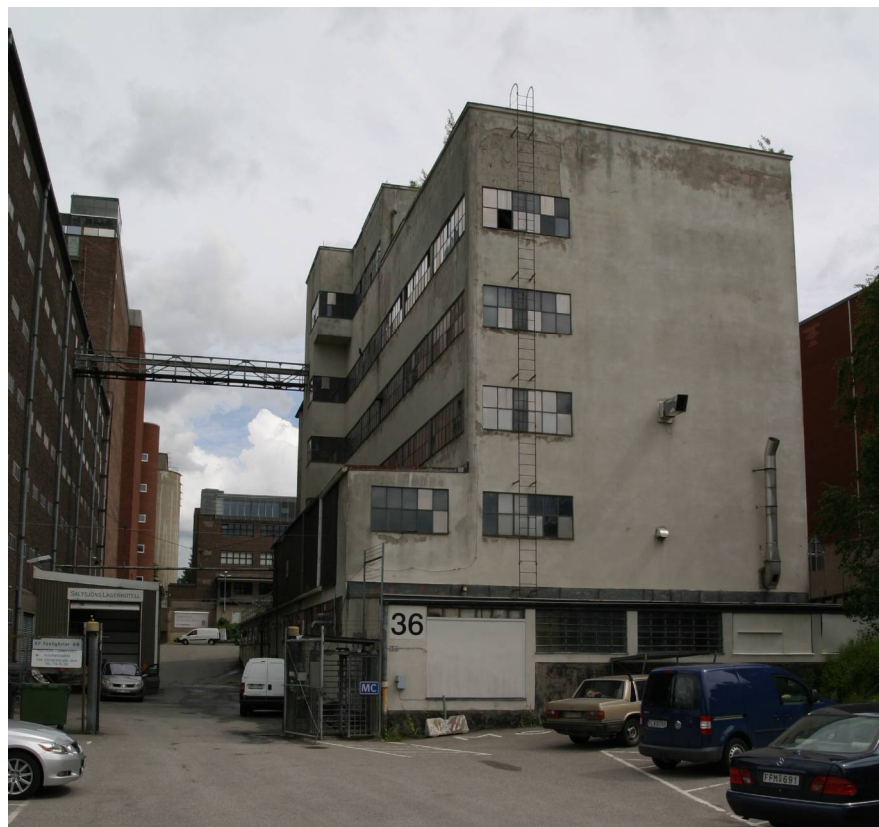
Vy mot öster. Befintligt utseende.
