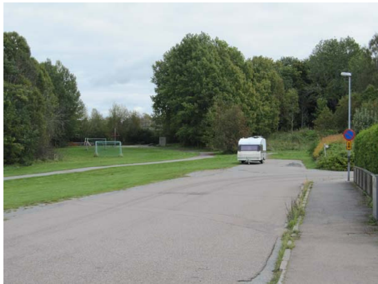
Området där Åkersbergsvägen kommer att ansluta till Vulcanusvägen. Vägen kommer att gå rakt igenom nuvarande lekplats och bollplan till vänster i bild. Lekplatsen och bollplanen flyttas i samband med att vägen byggs.
