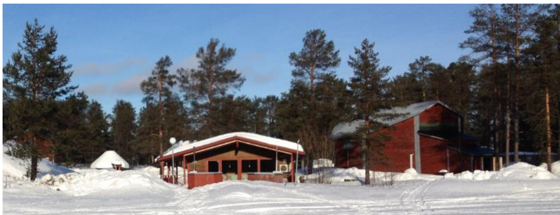
Figur 6. Servicebyggnad samt loge.
