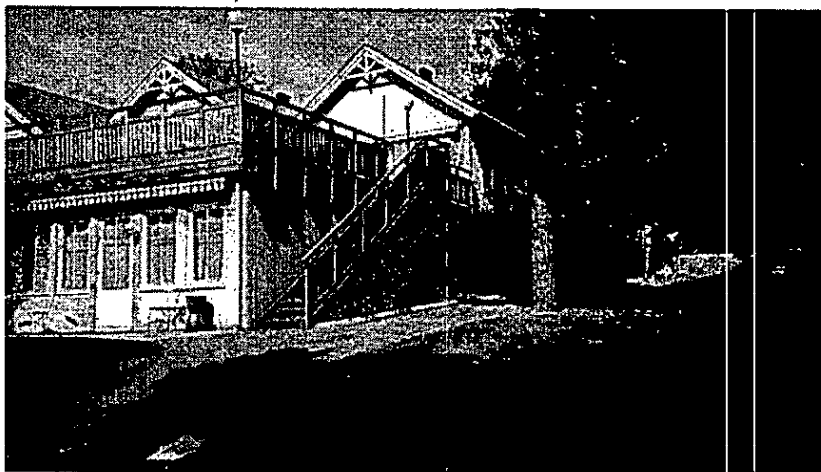
Centralbyggnadens östra del där utbyggnaden ska ske.
