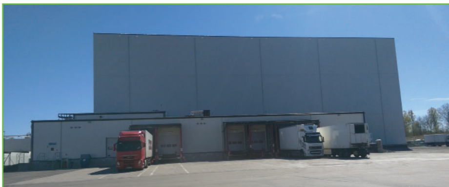
Befintligt höglager med dess utlastningsdel mot väster
