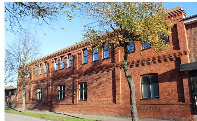
Huvudbyggnadens fasad mot Johan Kocksgatan uppförd 1899.
