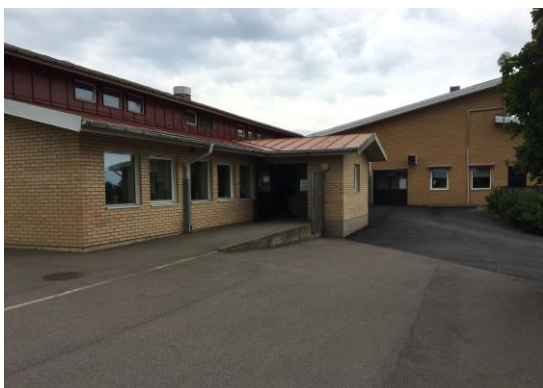
Till vänster: Skolbyggnad sett från sydväst.
