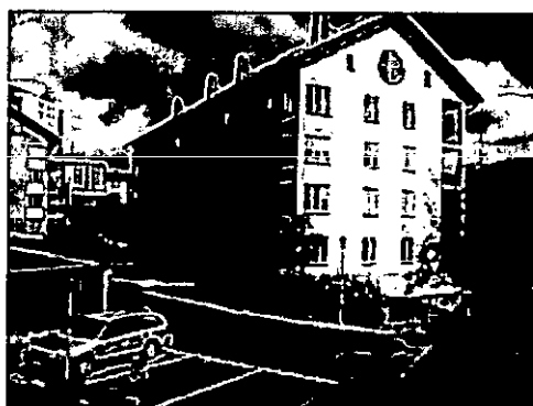
Närmsta huset i fastigheten Tjädern 28, takfot + 66 möh
