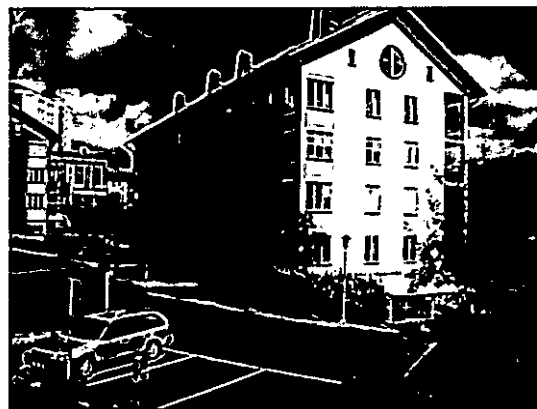
Närmsta huset i fastigheten Tjädern 28, takfot + 66 möh
