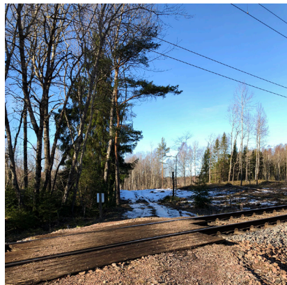
Oskyddad järnvägsöverfart som kan stängas.
