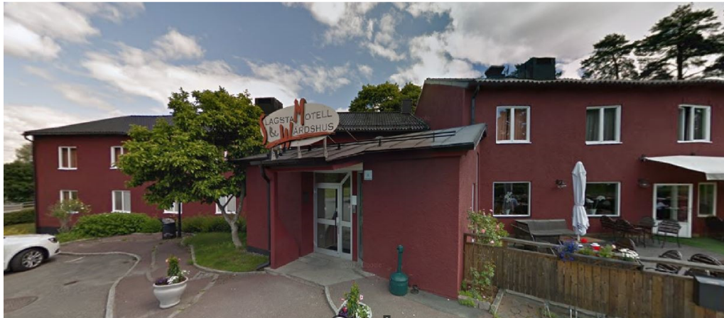
Vy mot befintlig byggnad från sydväst.
