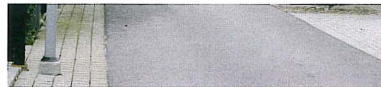
Körbana i asfalt och kanter i avvikande material gör att gatan känns smalare och hastigheten sänks.
