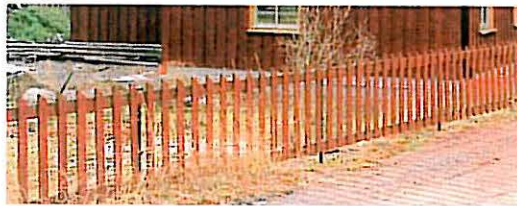
Bra exempel på utformning av staket.
