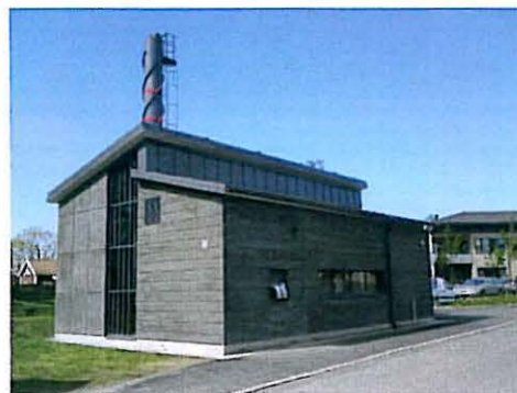
Fjärrvärmeanläggning vid Vicksa 1:124.
