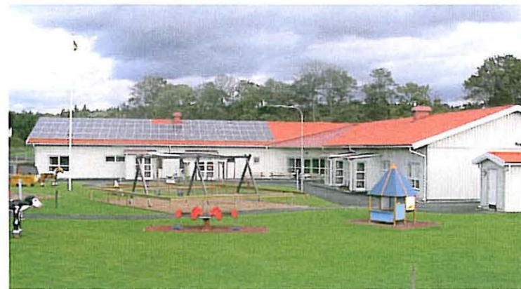
Förskola i Fjärås med solpaneler på taket, Må 1:3.
