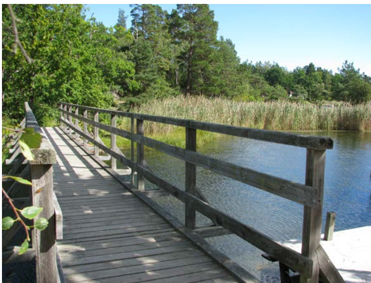
Gångbro över till Uvö.
