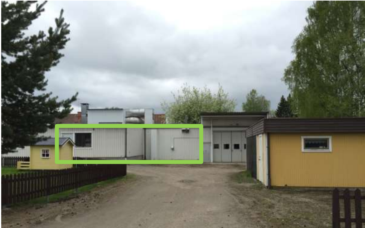
Bebyggelsen från Bondegatan – placeringen av tänkt tillbyggnad markerad. Ventilationsanläggningens placering i mitten av bebyggelsen.
