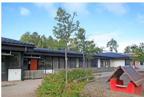
Den befintliga förskolebyggnaden som avses rivas (D)
