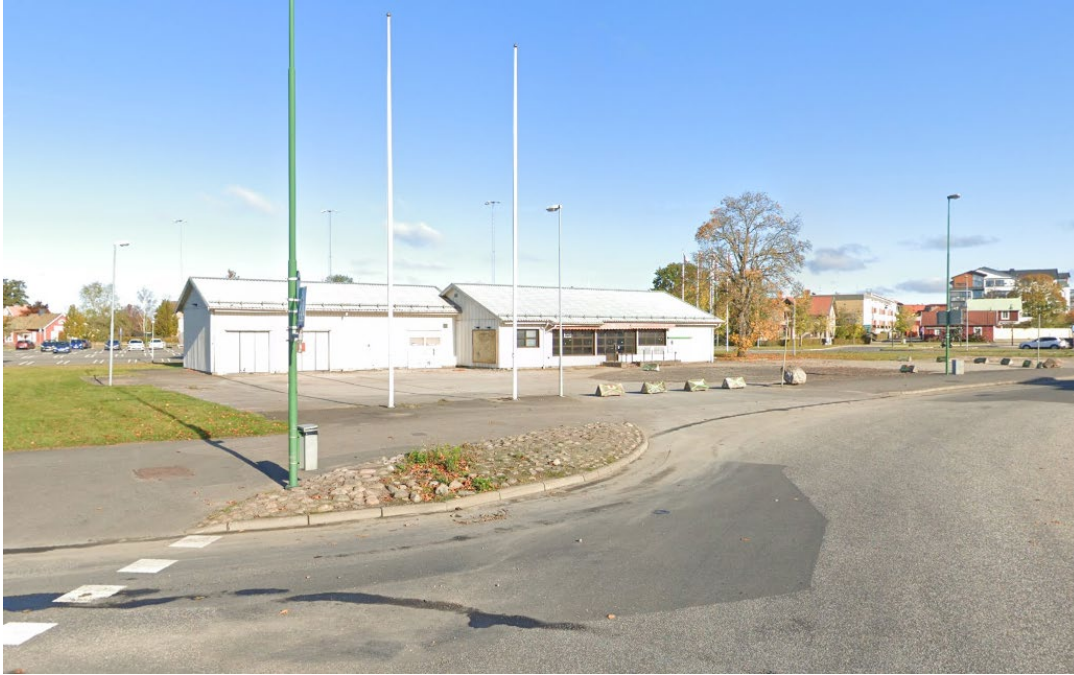
På bilden ovan syns huvudbyggnaden tillhörande Preems drivmedelstation på Tulpanen 8.
