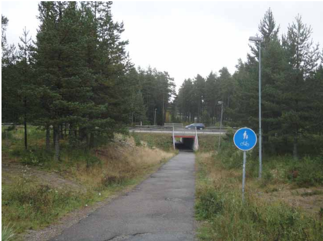
Befintlig gångtunnel under E4:an sedd från Terminalvägen
