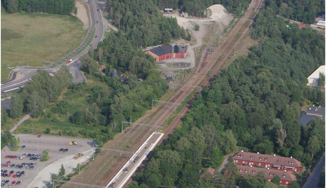
Lokstallet med bangården, pendlarparkering och Mästergatan (till vänster). Foto 2014-08-04.
