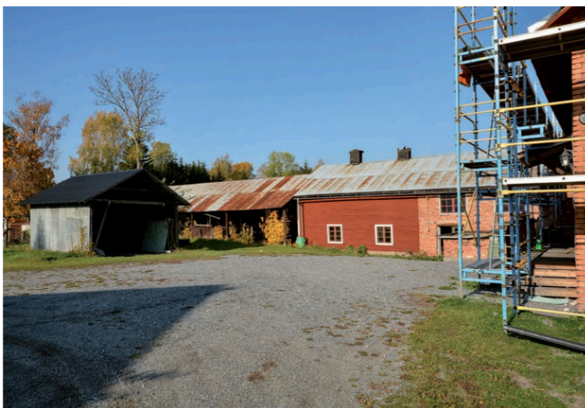
Snickerifabriken sedd söderifrån. Till vänster är det plåtskjul som sannolikt är tillkommet under fabriken sista verksamhetsår. Bakom det syns den öppna del som troligen fungerat som virkesupplag. Till höger ses tegelbyggnaden med byggställningar (SLM D2019-0276).
