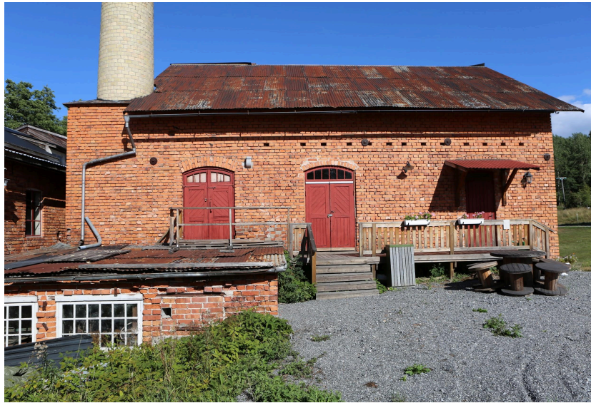
Tegelbyggnaden från väst. Notera monteringshål på bild till höger för skärmtak och pulpettak på lägre byggnad.
