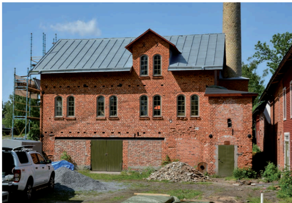
Tegelbyggnaden sedd från öster. Genom spår i fasaden kan man urskilja sågverkets takform vilket tidigare var byggt mot tegelbyggnaden. Den lägre utskjutande byggnadsdelen till höger innehåller ångpannan. Notera tegelväggen på röda byggnadslängan till höger, byggd som brandskydd mitt emot ångpannan (SLM D2019-0281).
