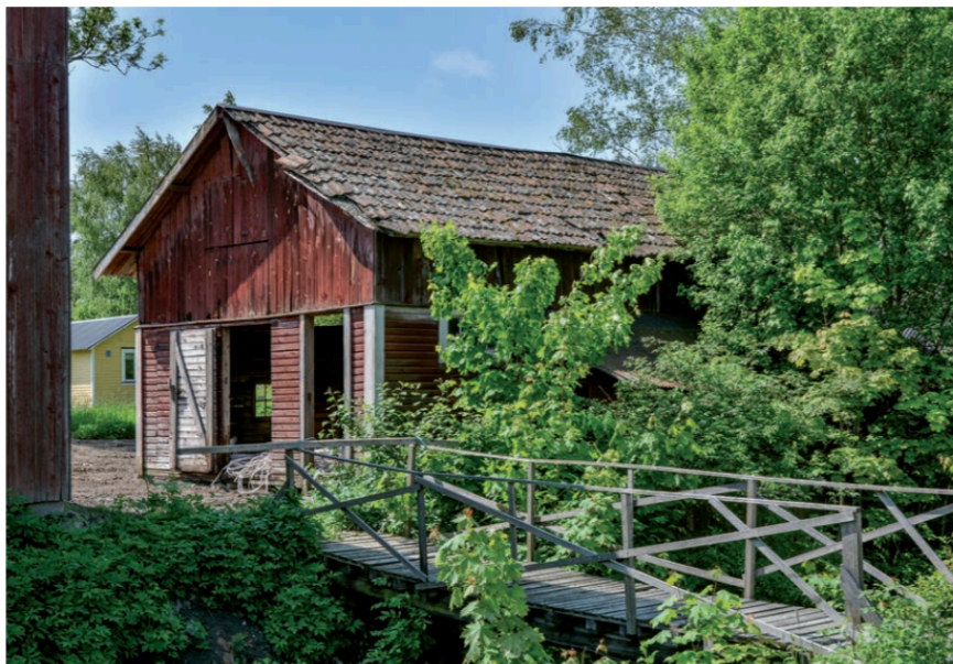
Den mindre fristående byggnaden väster om fabrikslängan sedd från norr. En gångbro av trä löper över ån (SLM D2019-0277).
