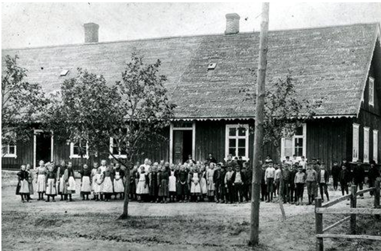
Den ursprungliga byggnaden, f. d. Kyrkskolan(nuvarande Snöstorpsgården), Snöstorps folkskola runt sekelskiftet 1900. Elever och skolpersonal har samlats för fotografering framför skolbyggnaden.
