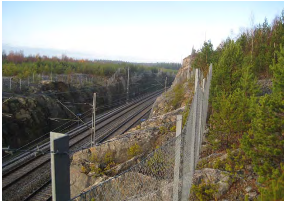
Svealandsbanan går i schakt nedanför planområdet.
