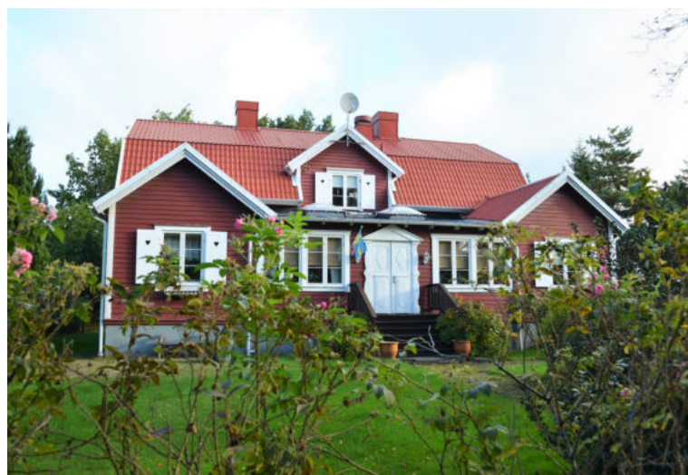
Storahult har höga kulturvärden med äldre gårdsbebyggelse och fäladsmark. Bilden ovan visar Surahammarkolonin, en barnkoloni byggd under 1920-1930-talet vid Storahultsvägen
