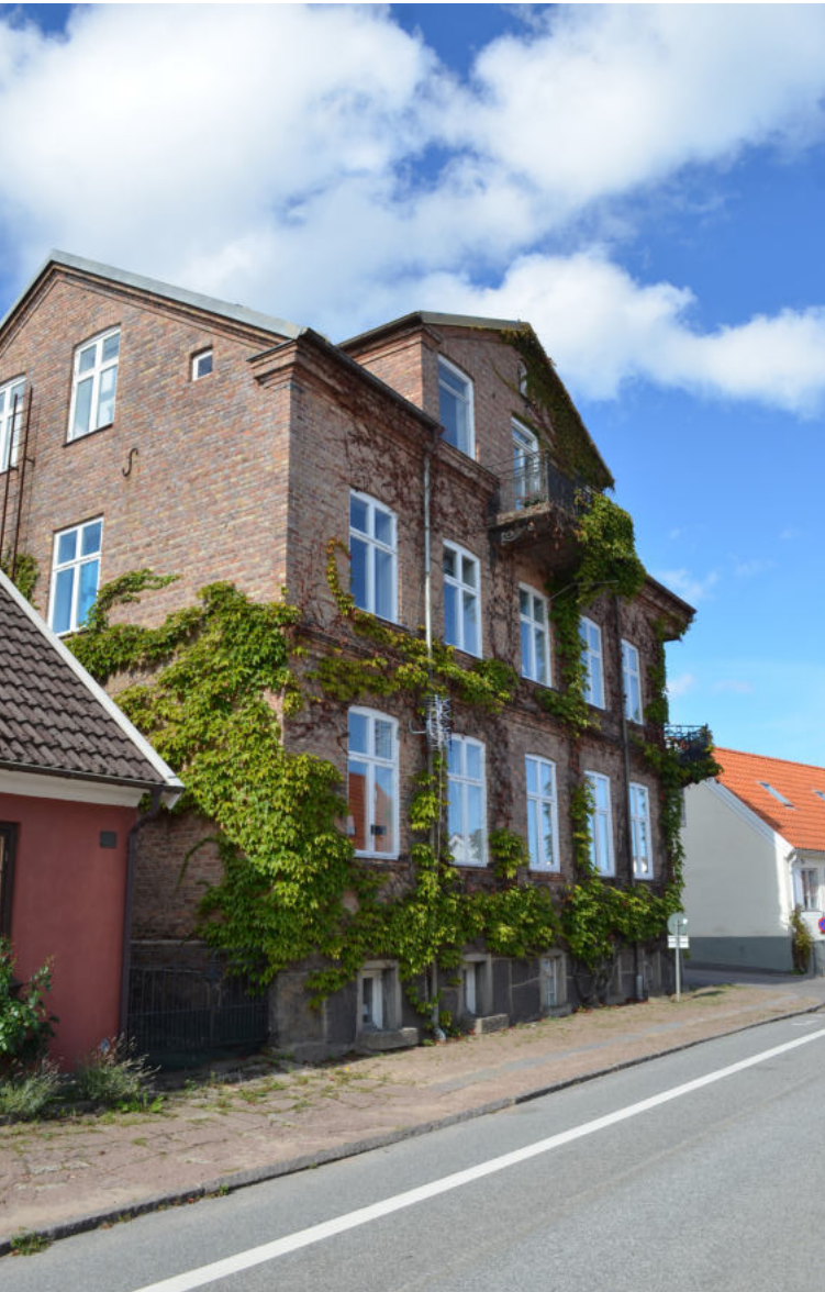
En byggnad som med sin höjd, robusta karaktär och tegelfasad sticker ut på den i övrigt småskaliga bebyggelsen på Agardhsgatan
