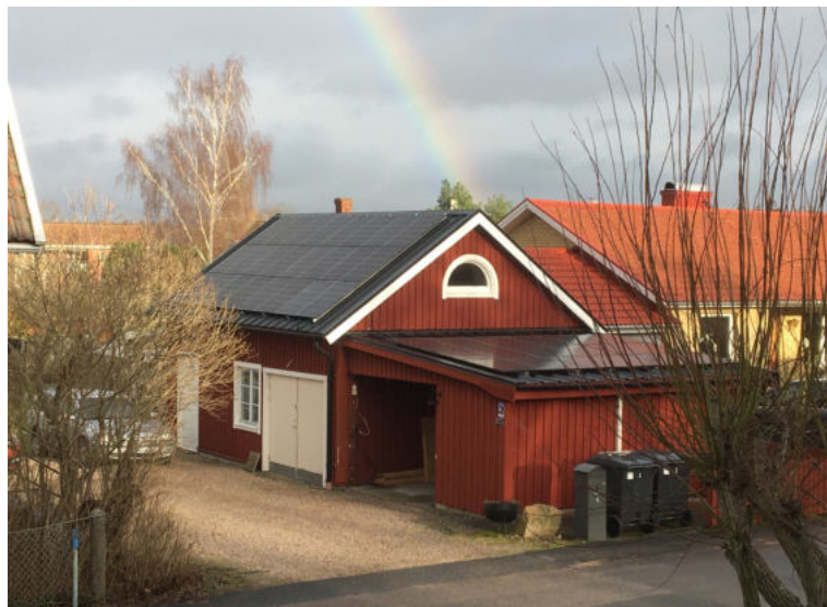
Nedan: Svarta solceller på ett svart tak gör att panelerna smälter in mer i det underliggande materialet. Det är även lämpligt att, som i detta fall, montera solpanelerna på en komplementbyggnad istället för på huvudbyggnaden
