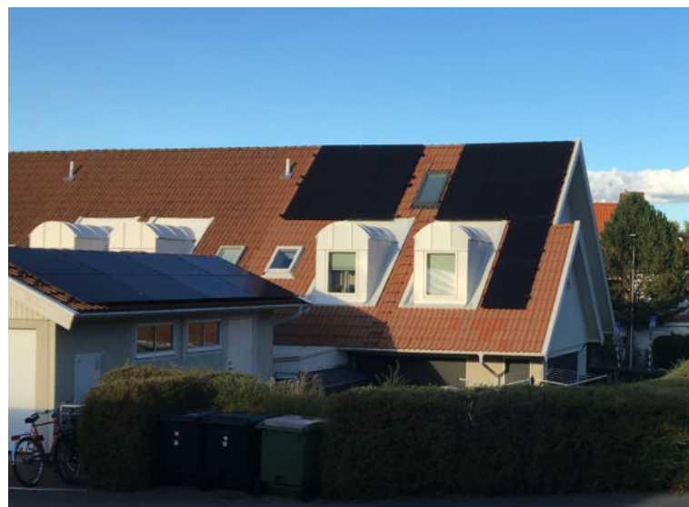
Ovan: Exempel på montering av solceller där man inte tagit hänsyn till byggnadens karaktär och där panelerna är monterade asymmetriskt och synliga från gatan. På garagebyggnaden smälter solpanelerna in bra.
