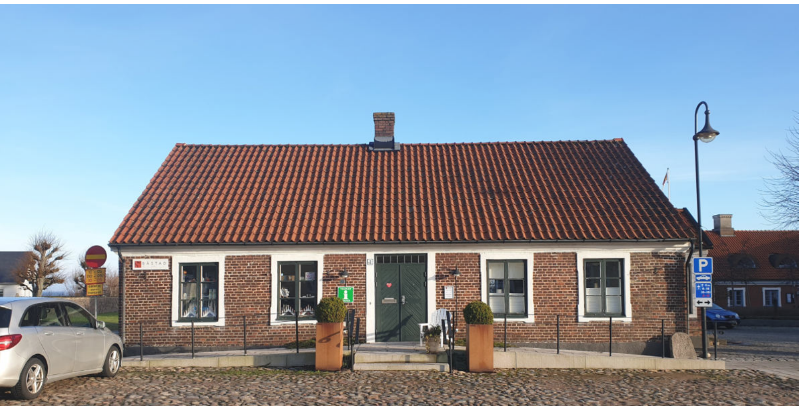
Tillgänglighetsanpassning vid entrén till Båstads turistbyrå där ramper byggts på ömse sidor om trappan vilken har flyttats ut från fasaden.
