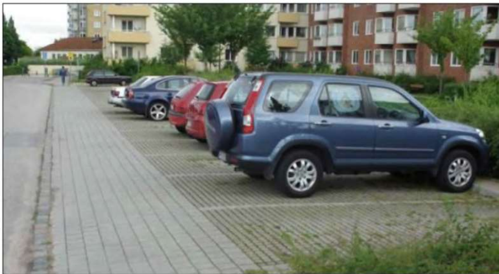
Figur 45 – Ett exempel på gräsarmerande betongbeläggningar.
