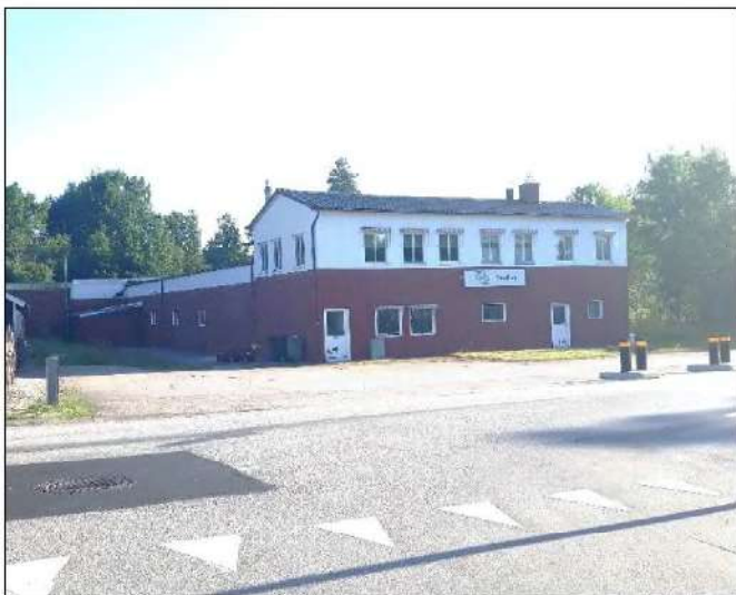
Figur 6 – Befintlig verkstadsbyggnad på Kärr 15
