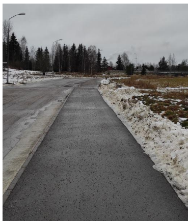
GC längs Idrottsvägen. Vy åt norr.
