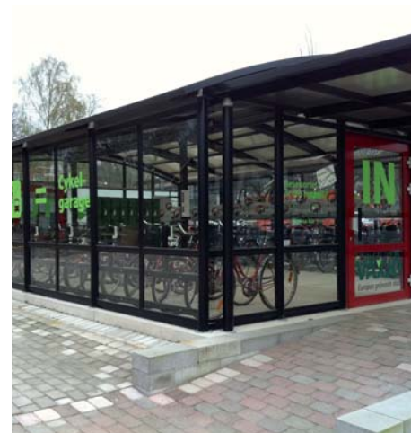
Cykelgarage, exempel från Växjö
