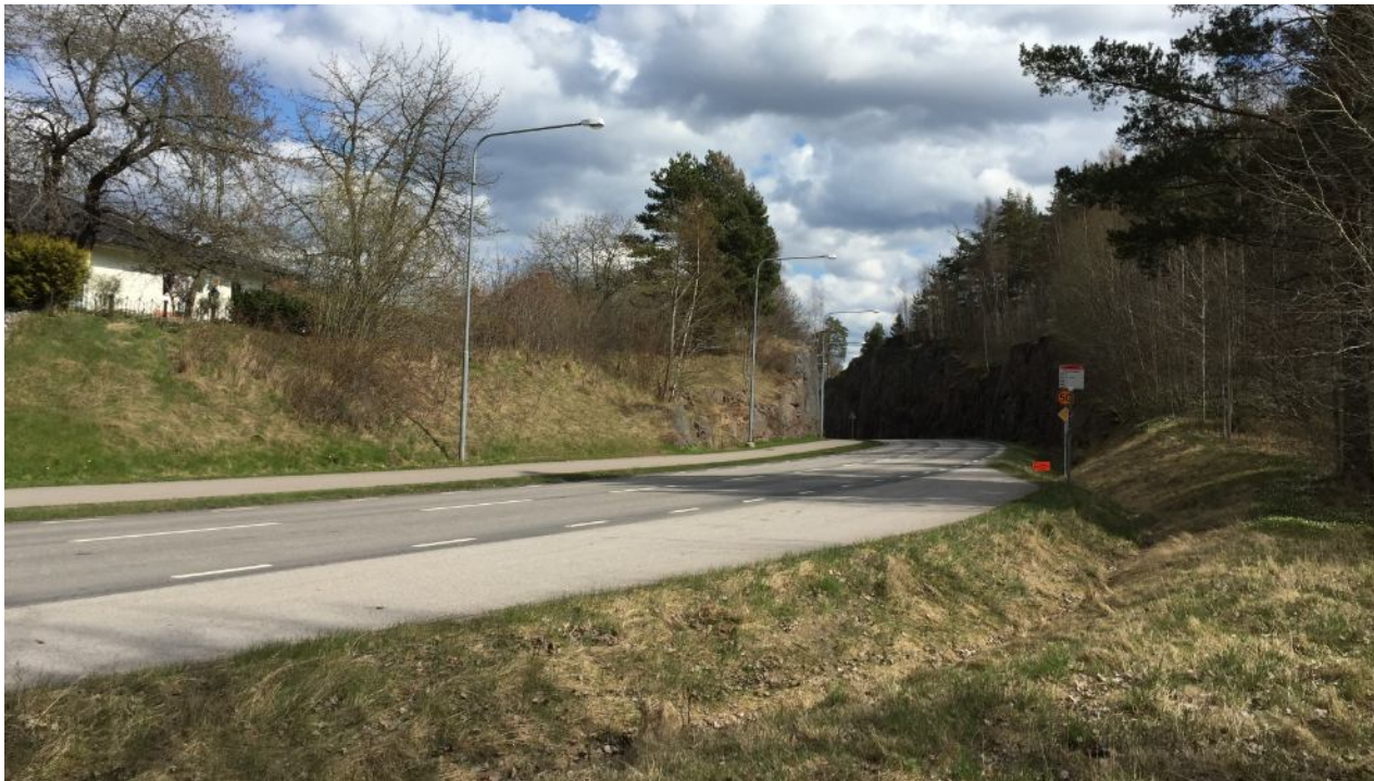
Busshållplatsen längs Industrivägen. Planområdet till höger i bild.
