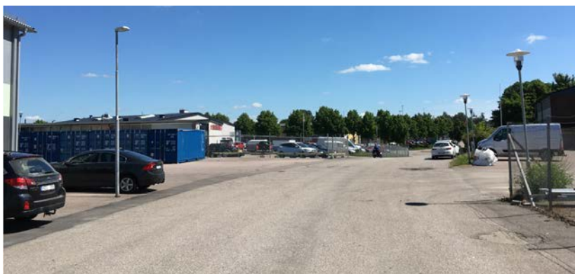
Västra Järnvägsgratan mot öster och Salavägen. Området till vänster vid blå containrar ges ändrad markanvändning: T 1 – Trafik.
