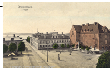
Till vänster gamla apotekshuset, i mitten Hotell Örn och till höger Sparbankshuset. På tomten för Sparbankshuset stod tidigare bl.a. handlaren Ödbergs gamla drängstuga. Sparbankshuset som stod klart 1913 är en byggnad i utpräglad nationalromantik. Källarmästare L. L. Jansson köpte 1878 den Ödbergsgården och etablerade efter en ombyggnad Hotell Örn. En brand 1936 ödelade hotellet.
