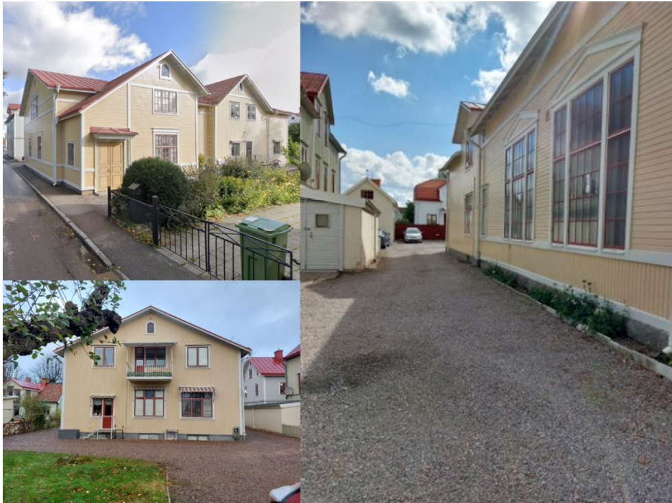
Figur 13: Byggnaden i sitt nuvarande skick
