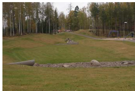
Exempel på fördröjningsmagasin intill lekplats
