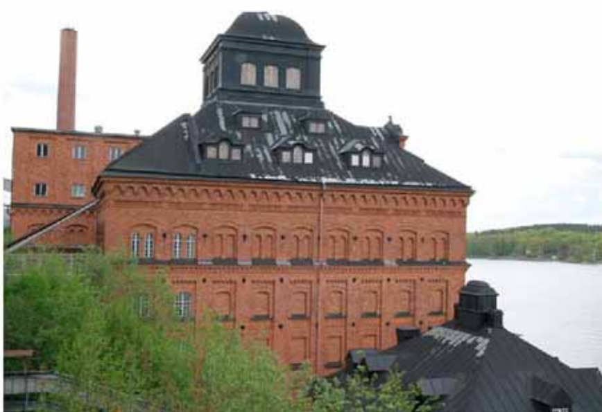
Fasad och tak mot öster.
