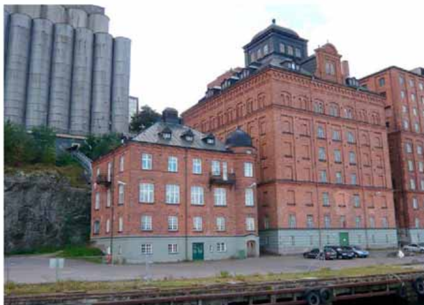
Hus 01 sett från nordost.
