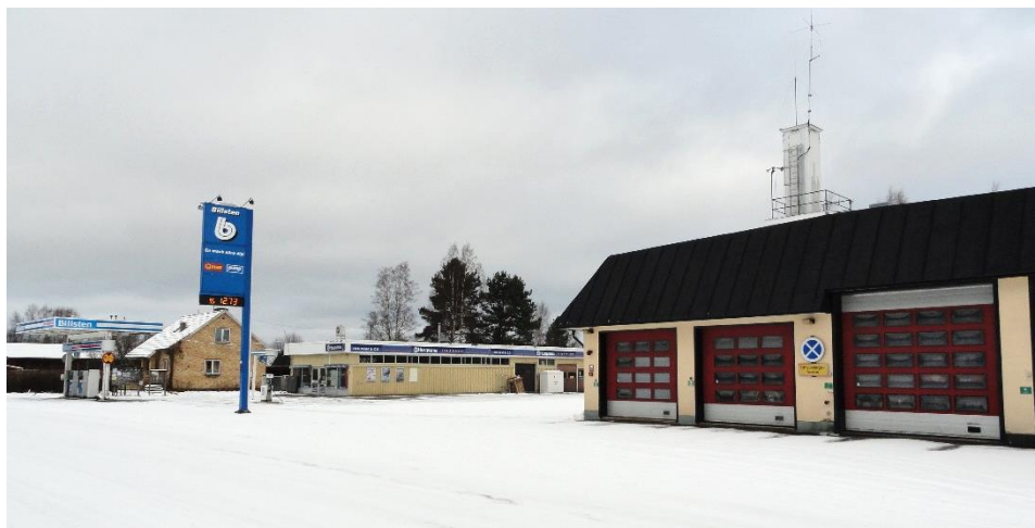
Bensinstationen och brandstationen är belägna längs Björbovägen.
