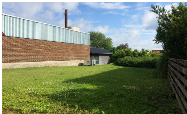
Kv. Banken 1, grönyta angränsande mot kv. Banken 8
