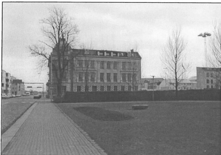
Byggnaden på Havsörnen 2 sedd från Kungsgatan.
