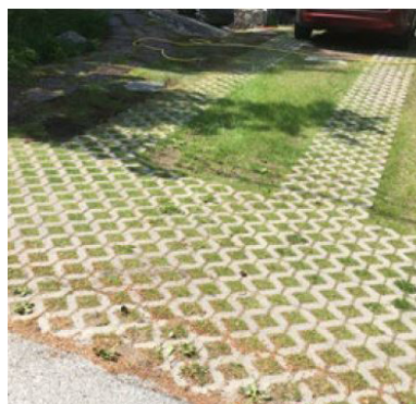
Exempel från Järfälla på genomsläpplig markbeläggning för biluppställning på kvartersmark
