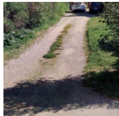
Exempel från Järfälla på genomsläpplig markbeläggning för biluppställning på kvartersmark
