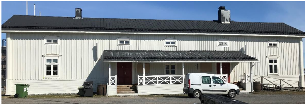
Figur 8 Byggnad 2 på gårdens norra del (foto Ramboll 2019).
