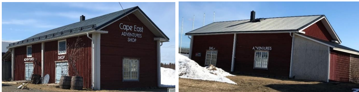
Figur 9 Byggnad 3 på gårdens västra del (foto Ramboll 2019).
