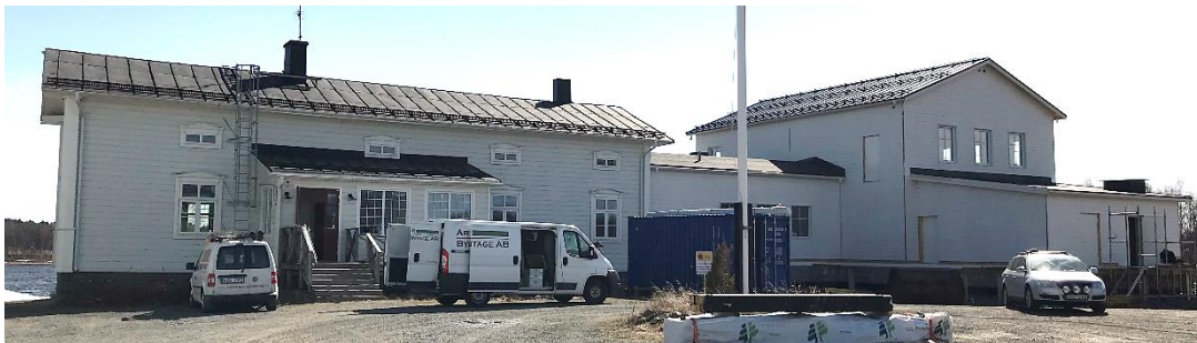
Figur 7 Huvudbyggnaden där tillbyggnad av restaurangen är under uppförande (foto Ramboll 2019).
