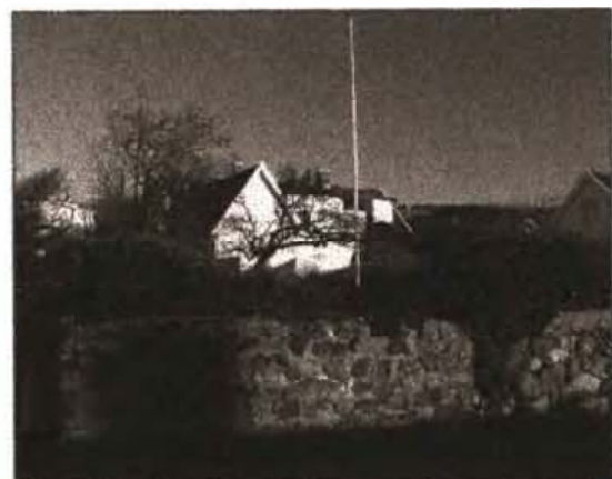
Befintlig skyddsvärd mur
