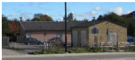
Bild tagen på transformatorstationen i förgrunden och samlingslokalen/tvättstugan.
