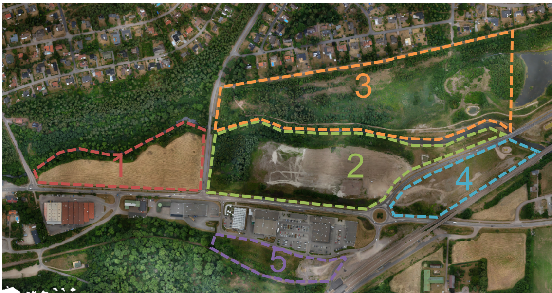
Figur 2. Ortofoto utfört av Civil Drone Service AB under Juli 2018 med inringade delområden.
