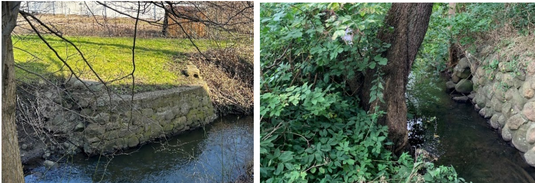
Södra fundamentet (till vänster) och motstående sidas stenskodda strandbrink i höjd med det södra fundamentet (till höger).
