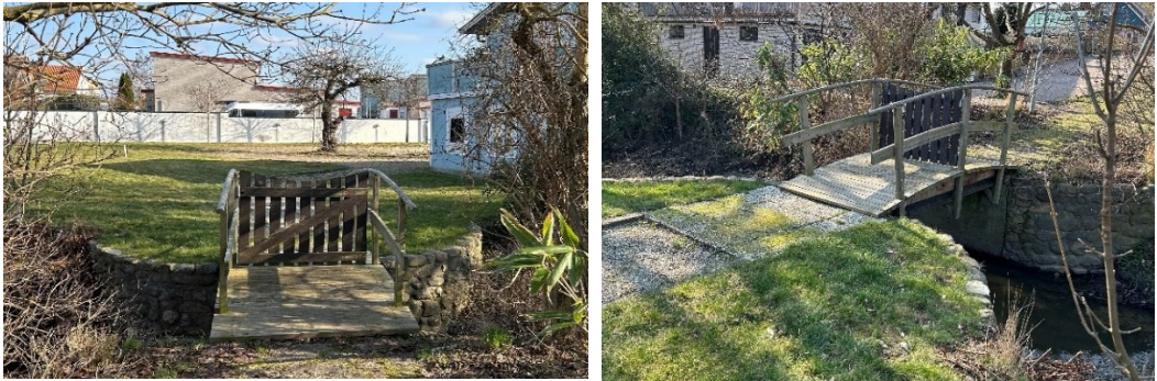
Brofundament sett från väster (till vänster) och från öster (till höger).
