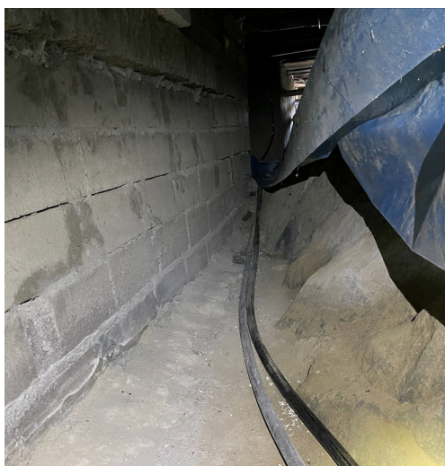
Bild 2. Befintligt bostadshus är grundlagt direkt på berget.
