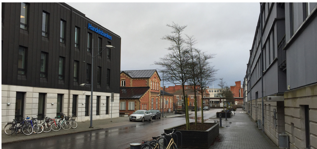
Bild 10. Intilliggande kontors- och konferensbyggnader samt äldre kulturmiljöbebyggelse.
