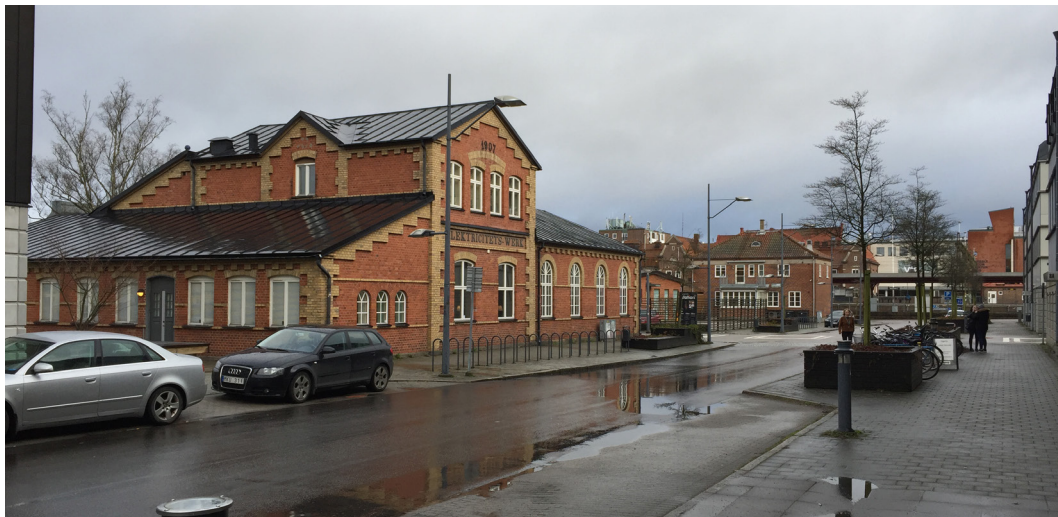
Bild 16. Gamla elverket (t.v.) och disponentvillan (t.h.)
