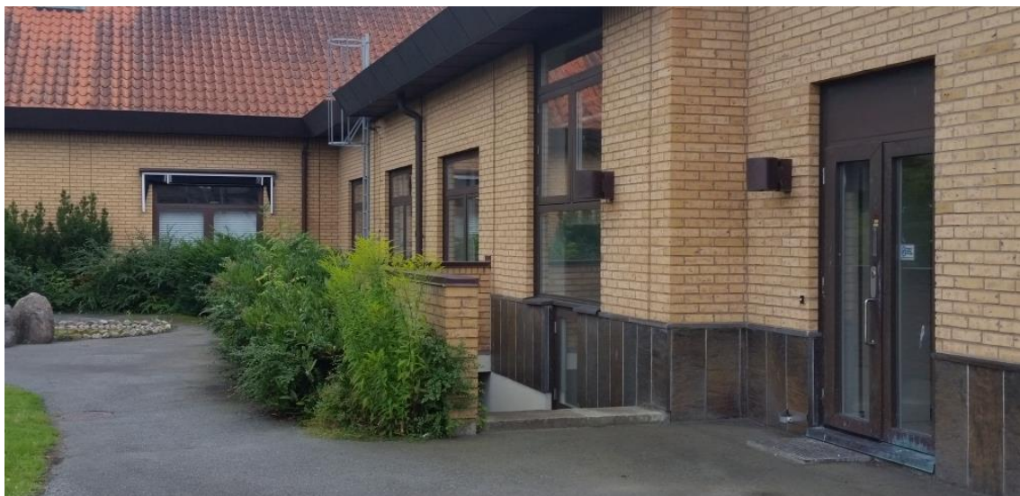
Byggnaden från gårdssidan
