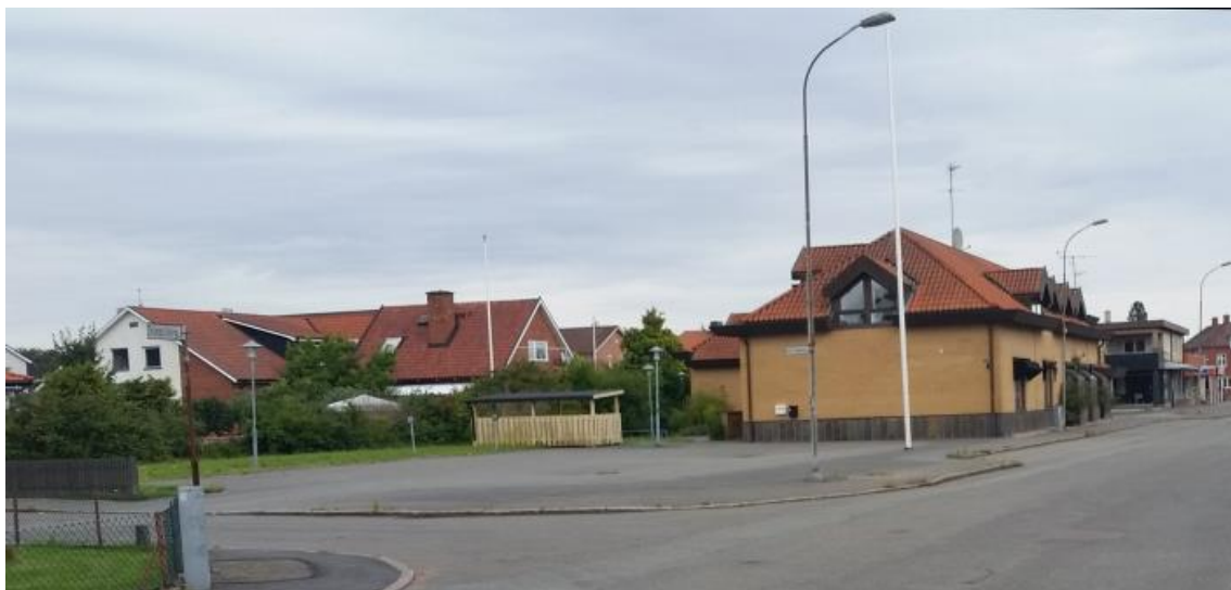
Fastigheten från Tollarps storgata.
