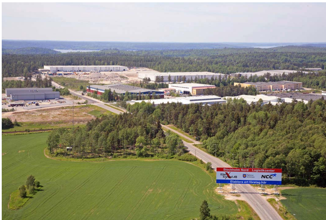
Befintliga verksamheter i Rosersbergs arbetsområde, vy från öster. Foto Rosersbergs Exploatering AB.
