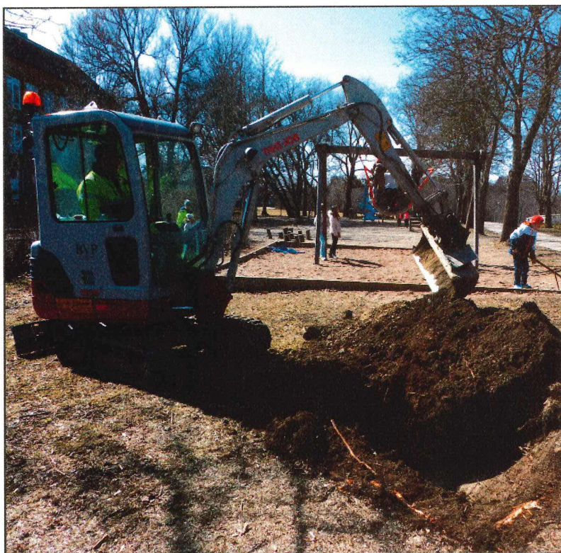
Fig. 3. Objekt 2, schakt 2, grävdes nära inpå skolbarnens lekplats och ett tiotal meter söder om de kända Släbroristningarna. Schaktet var fyndtomt.
