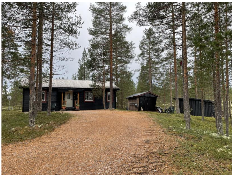
Bild på befintliga byggnad inom planområdet.
