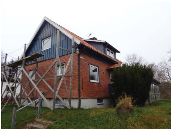
Befintlig byggnad på fastigheten Hulabäck 1:14 avses att rivas
