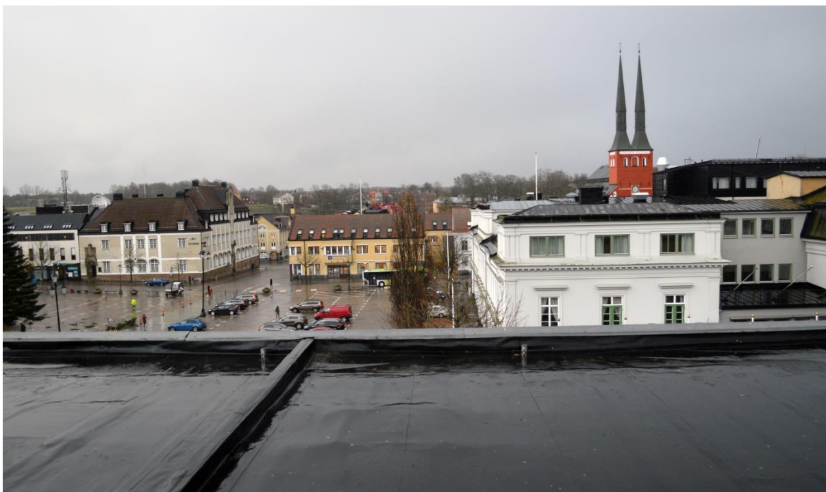
Siktlinjer mot öster från nuvarande tak på fläktaggregatsbyggnaden vilken på ett ungefär kommer utgöra taknivån på våningstillägget.
