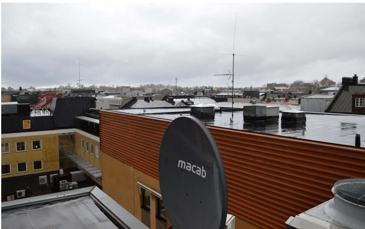
Siktlinjer mot väster från nuvarande tak på fläktaggregatsbyggnaden vilken på ett ungefär kommer utgöra taknivån på våningstillägget. Här syns även inbyggnationen av fläkthuset på huskroppen mot Storgatan.
