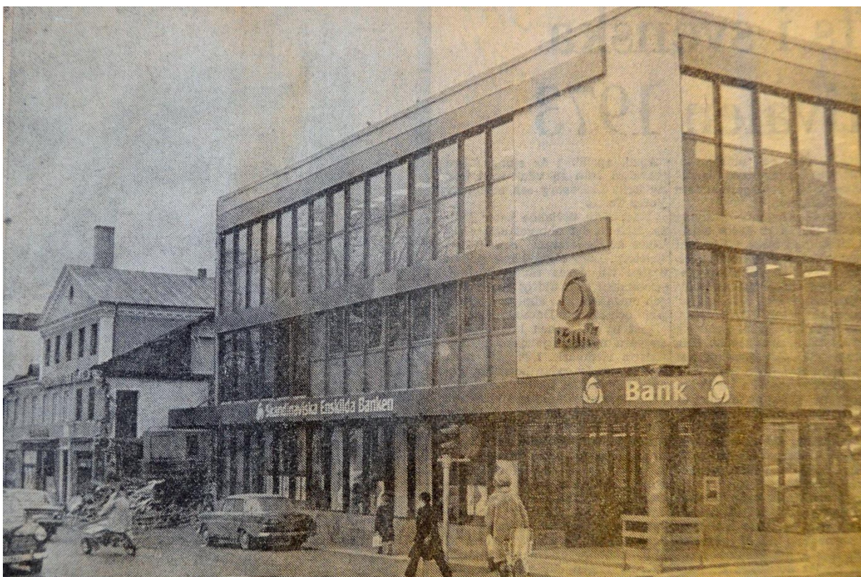
Smålandsposten den 10 februari 1973. Etapp I (hörnhuset) är färdigt och rivningen har just inletts för etapp II, bakkdelen på grävsloppet anas mellan huskropparna. Smålands museums klipparkiv
